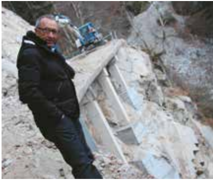
Der Vizebürgermeister Horst Margesin auf Baustellenbesichtigung im Höllental.
